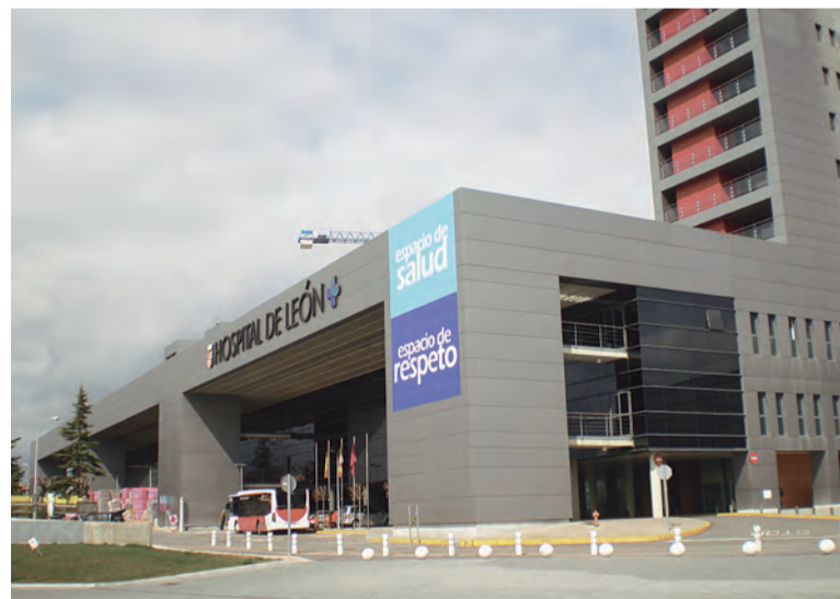
Imagen exterior del Hospital de León
